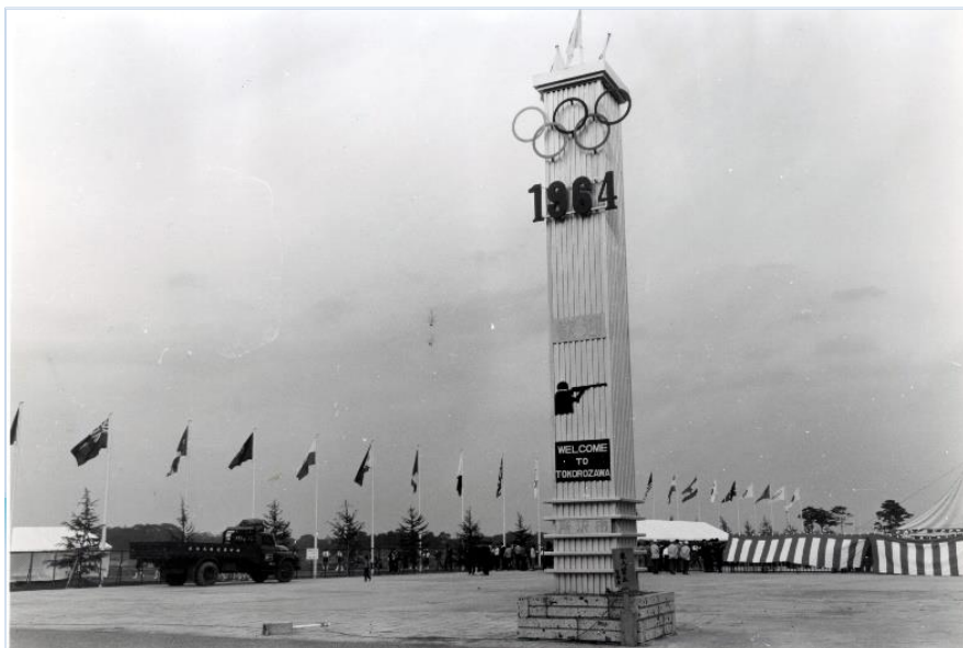
オリンピック所沢会場完成 昭和39年8月撮影
